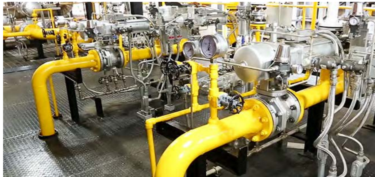
친환경 연료 LNG만을 사용하는 울산Complex 동력보일러
